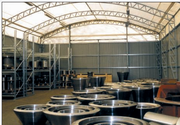
PMH Combihall har pelarfri golvyta och ljusgenomsläppligt tak.
