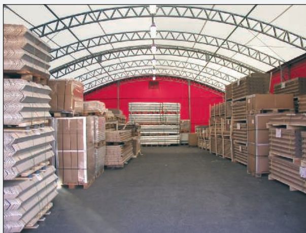
PMH Hyrhall har pelarfri golvyta och ljusgenomsläppligt tak.
