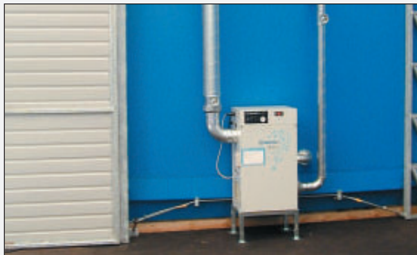
PMH Torrluftlager är som standard utrustad med avfuktare.
